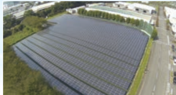
赤堀工場 発電データ
